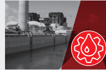
Tratamiento de agua Water treatment
