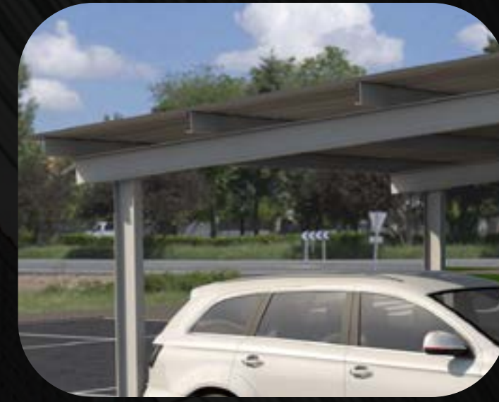
Marquesinas de aparcamiento
