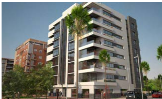
Edificio Aladas, Murcia
