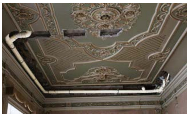
Rehabilitación de Palacete en Plaza Manises, Valencia
