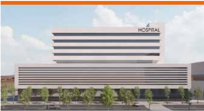
Hospital Sanitas Valdebebas - Madrid
