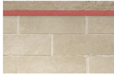
Aplicación en juntas de construcción
