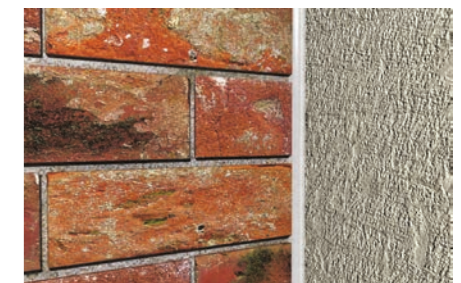
Aplicación en juntas de construcción verticales
