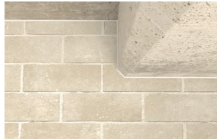
Aplicación de juntas de construcción
