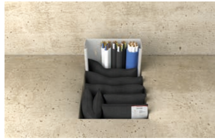
Aplicación eléctrica en suelo
