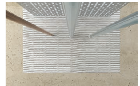
Paso de instalaciones mixtas a través de la pared
