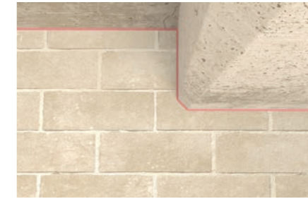
Aplicación en juntas de construcción
