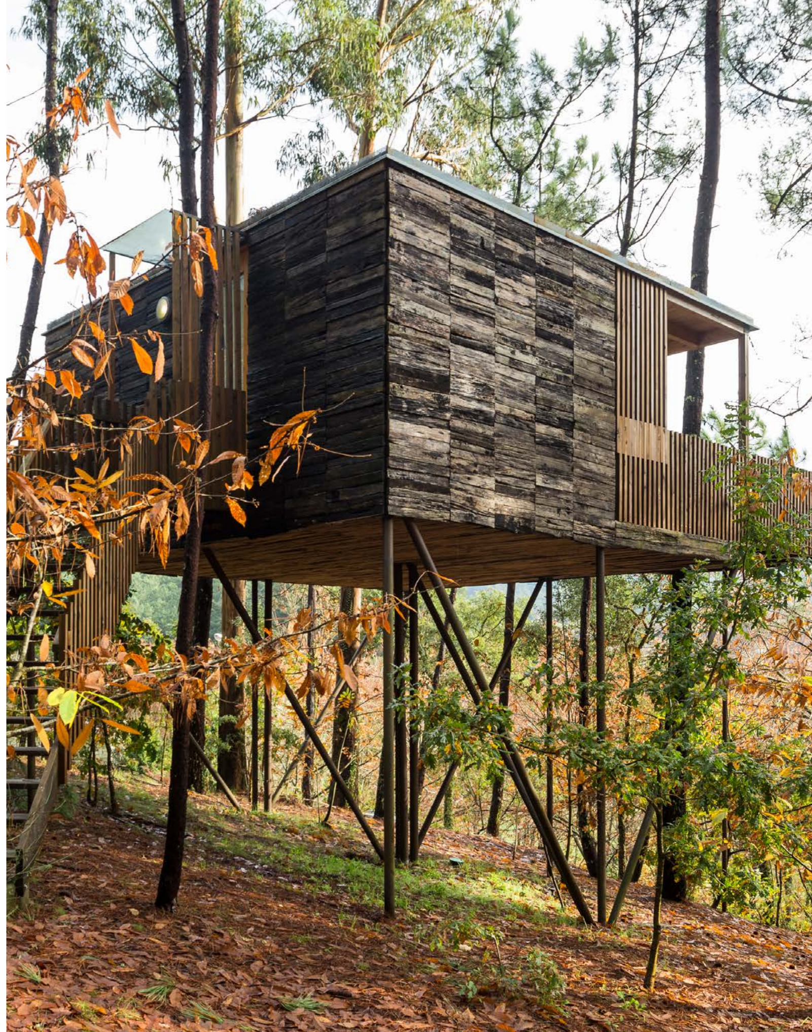
Cabañas en el bosque de Outes con instalación de aeroterminia Thermor.
