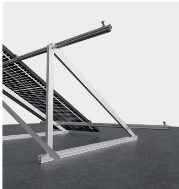
Instalación en cubierta de chapa.
