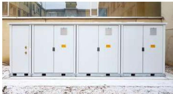
**Batería de condensadores MT automática de uno o varios pasos****Solución a medida**
