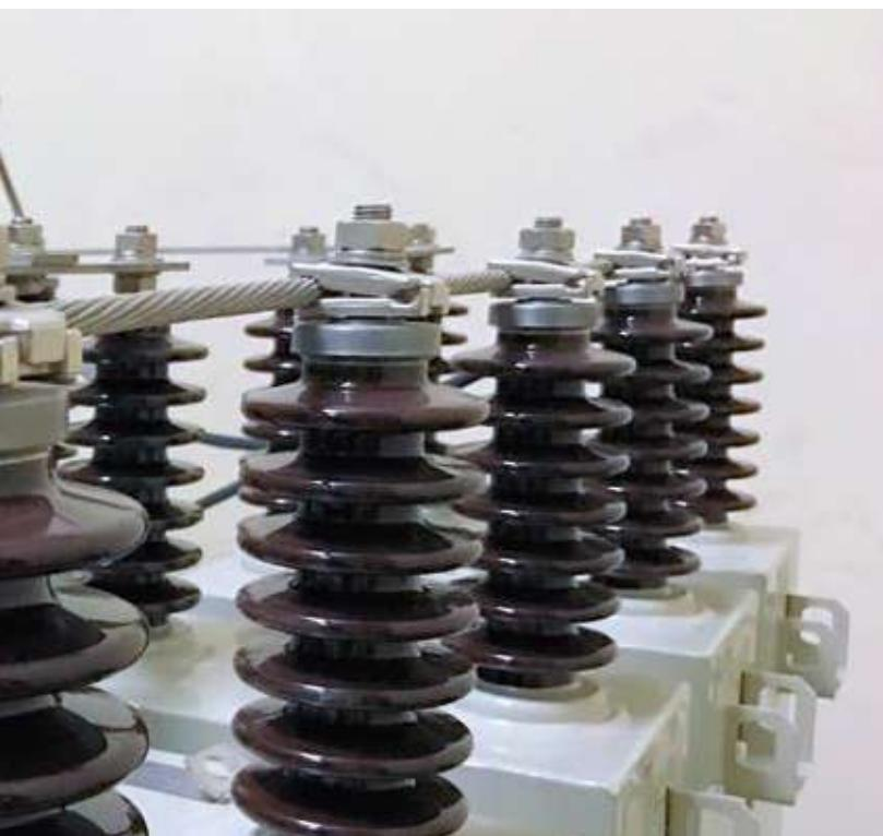
**Batería automática de condensadores MT multipasos****Ubicación exterior**
